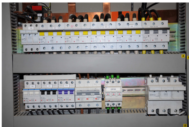
paralelní kabel pro CHILLER zapojit do OPV22
